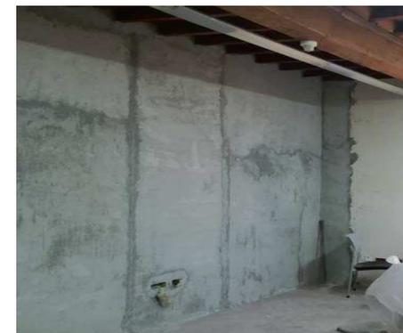
Foto del cantiere di una parete nelle varie fasi di intervento con intonaco armato GFRP
