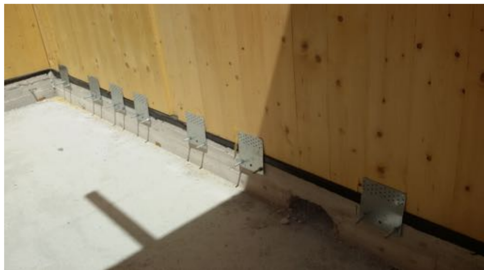
Foto dal cantiere
