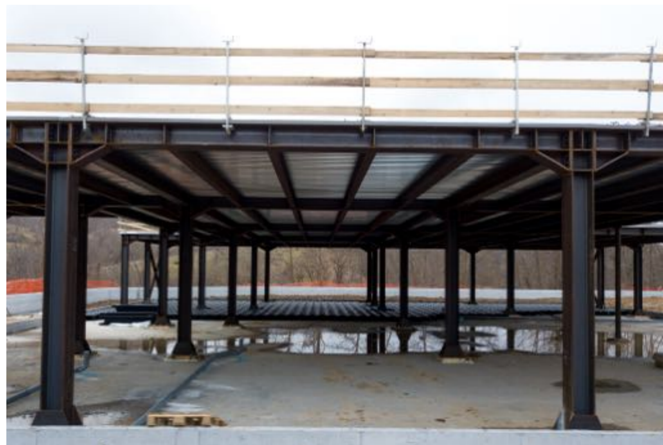
Scuola media | Fotografia dal cantiere
