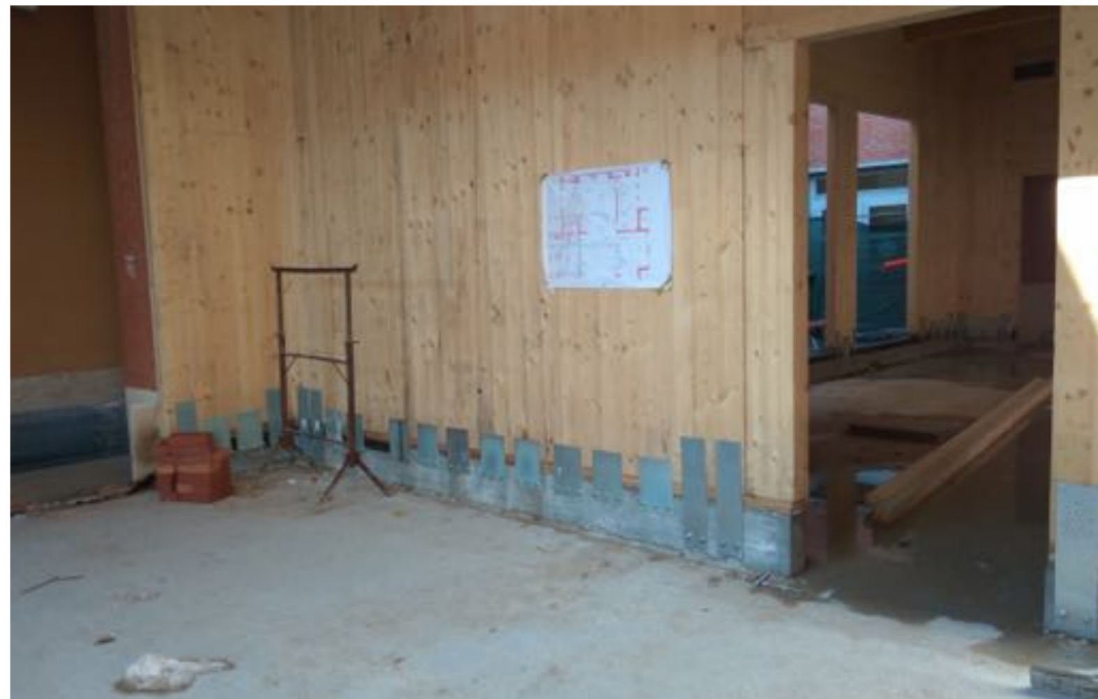
Ampliamento B | Fotografia dal cantiere (collegamenti XLAM)
