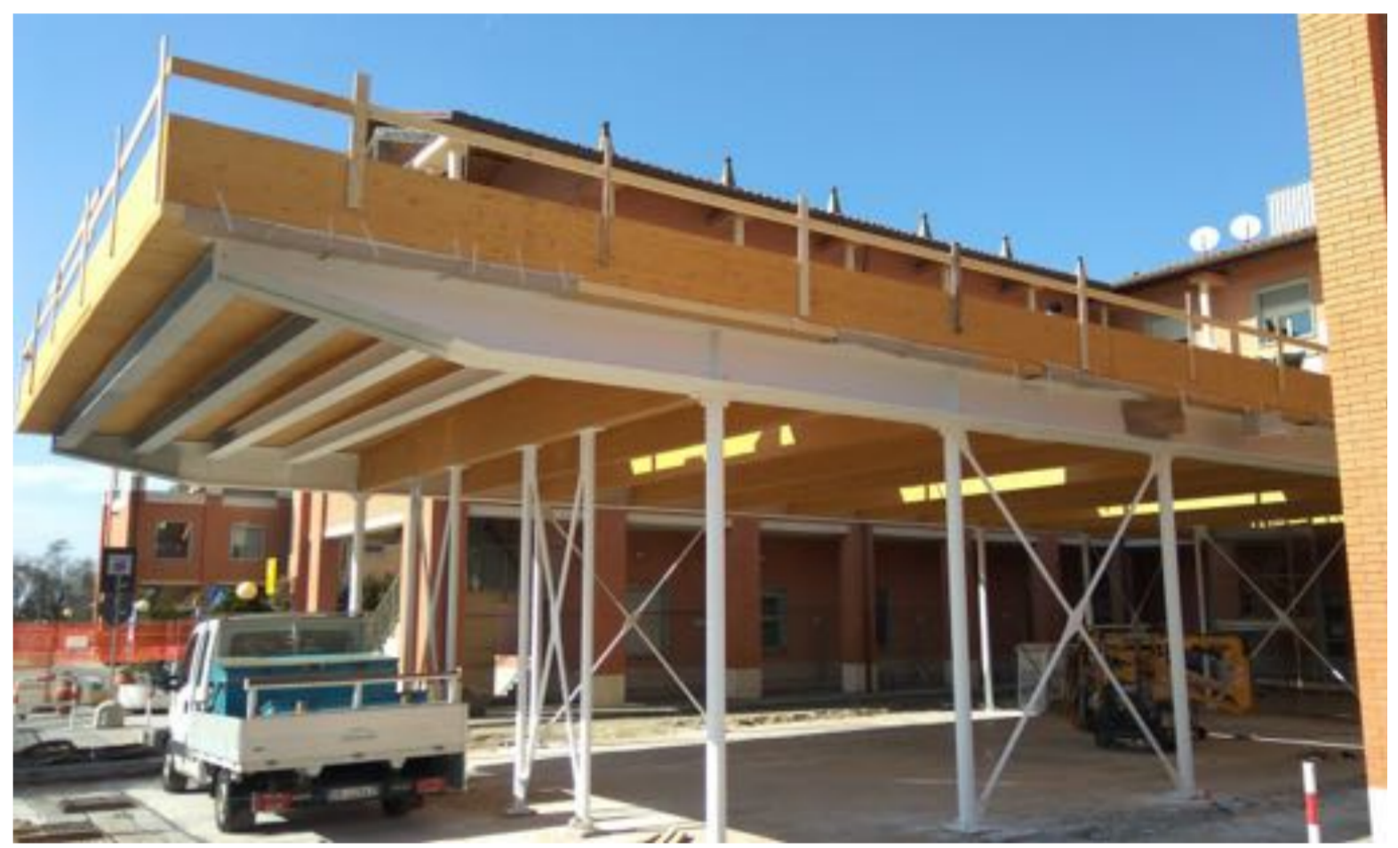
Ampliamento A | Fotografia dal cantiere
