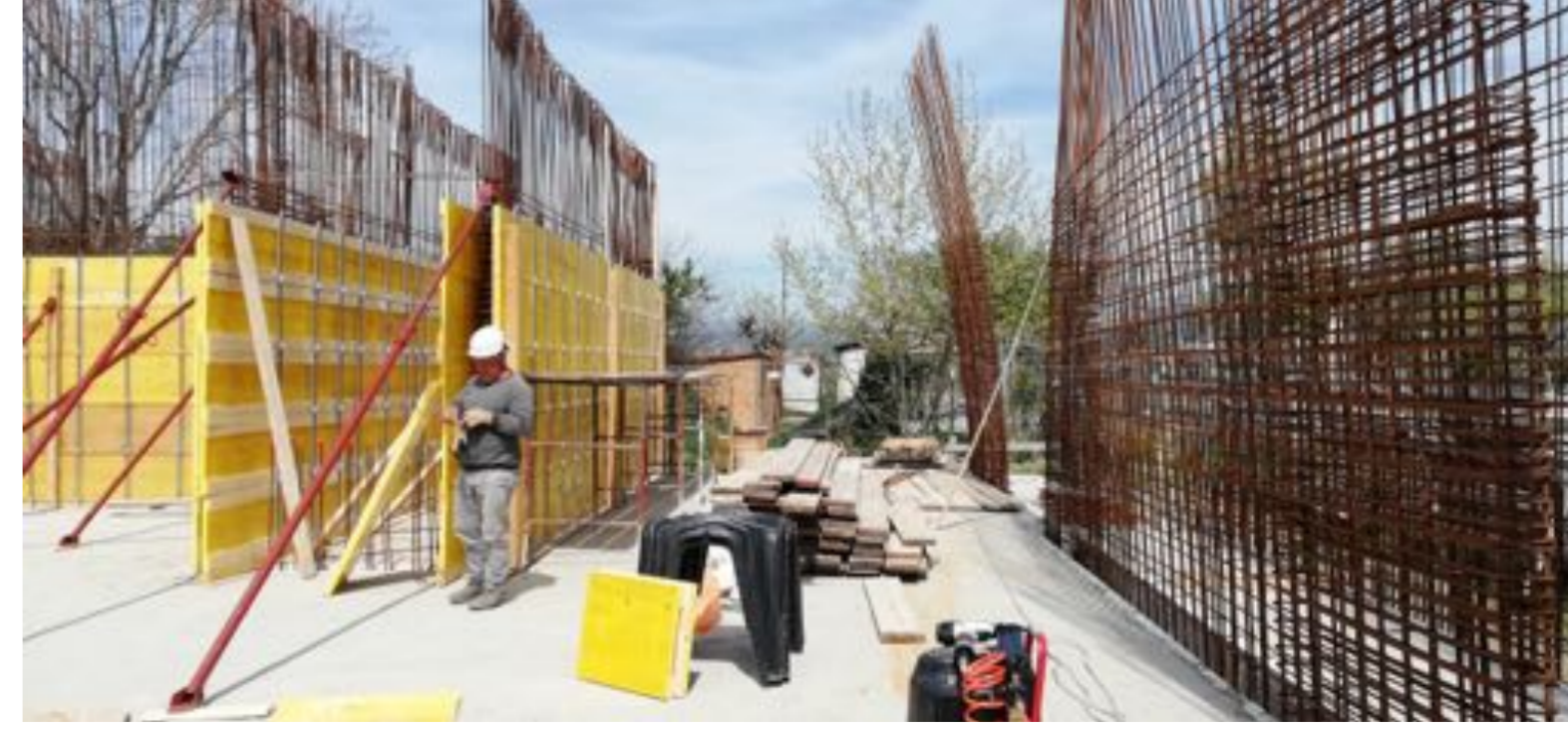
Foto del cantiere
