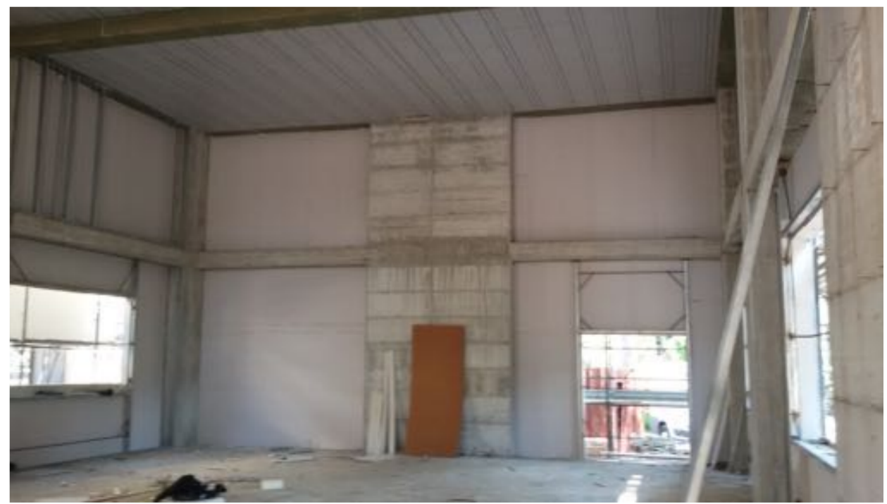
Foto dal cantiere
