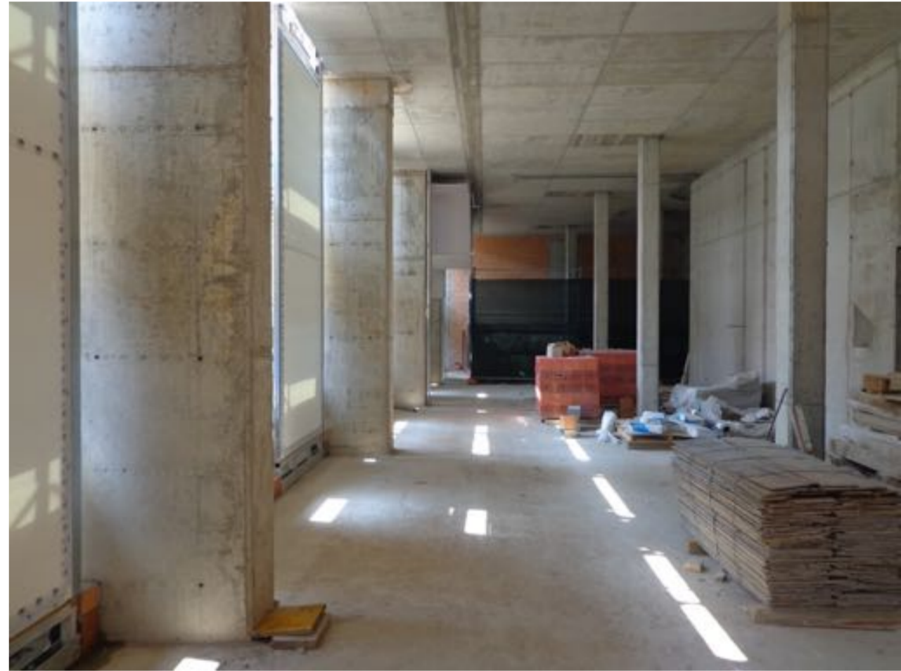
Foto dal cantiere - interno del piano interrato
