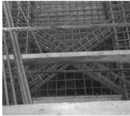
Fig. 5. Dettaglio dell'armatura a X dei "voltini" di collegamento fra nuclei
