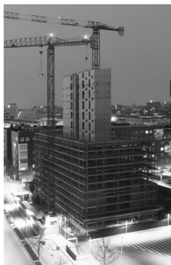
Fig.16. Nuclei completati
