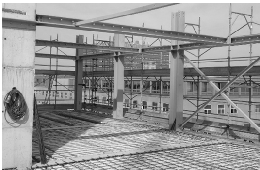
Fig. 9. Carpenteria metallica montata con controventi provvisori e impalcato armato in attesa del getto di completamento
