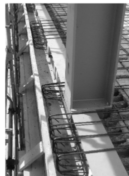
Fig. 10. Dettaglio dell'armatura di uno sbalzo
