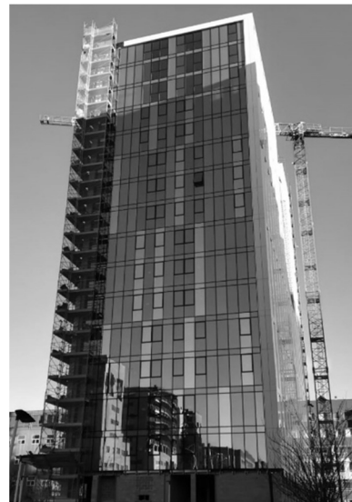
Fig. 2. Vista della Facciata Nord
